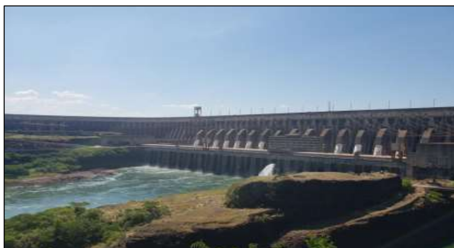
Imagem 1. Usina Hidrelétrica de Itaipu, localizada no rio Paraná, entre o Brasil e o Paraguai. Foto: Lucas Martins. Disponível em INFOESCOLA; https://www.infoescola.com/geografia/itaipu-binacional/ . Acesso em 13/06/2023.
